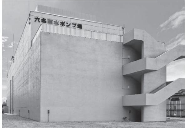
▲六名雨水ポンプ場施設(六名本町)
