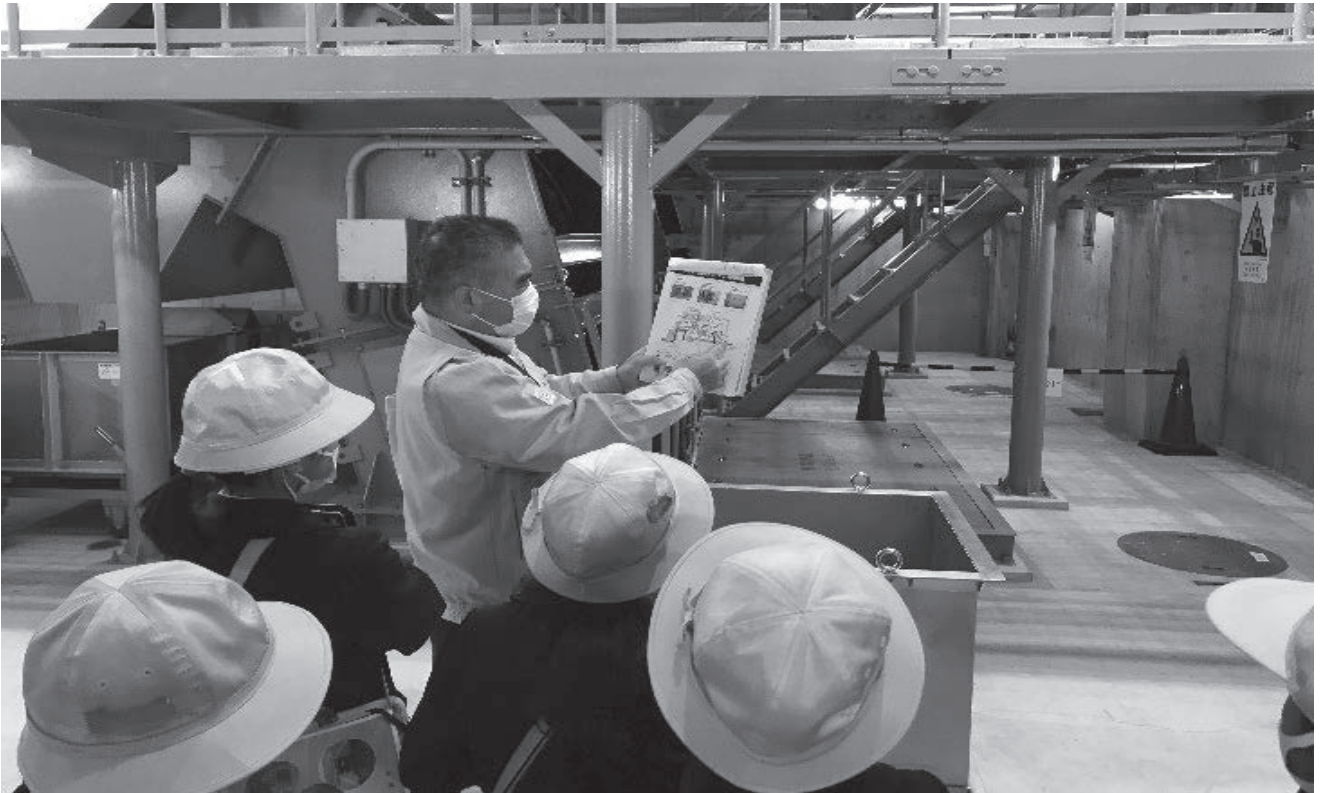
▲雨水ポンプ場施設の見学(六名小)
