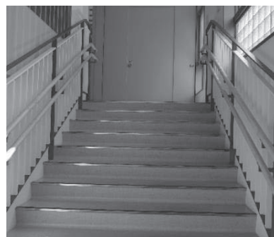
▲身長の違いに合わせた高さの違う二重の手すり
