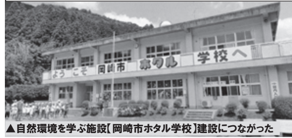
▲自然環境を学ぶ施設【岡崎市ホテル学校】建設につながった
