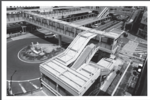
▲ ペDESTリアンデッキ完成 現在の岡崎駅（令和元年）
