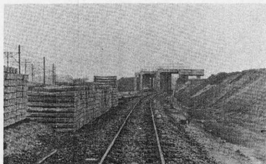
工事中の六名付近 昭45.5
