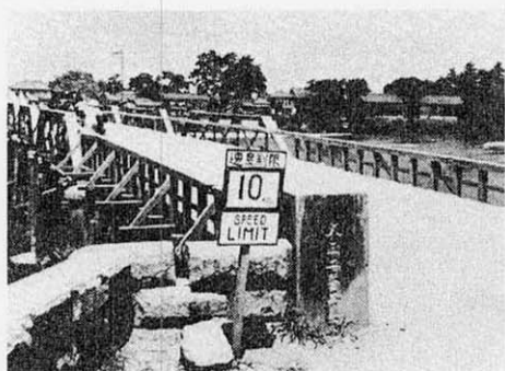
大正2年に架橋された矢作橋
