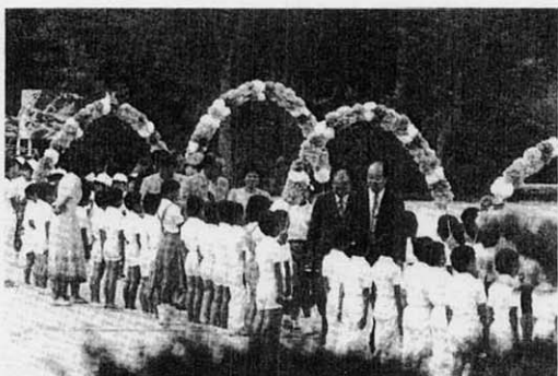
▲校舎完工式に大浜小学校の方々を招待 (昭和58年)
