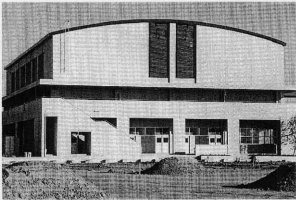
福岡中屋内運動場建設 (平成6年度)
