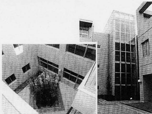
▲吹き抜けの中庭と、近代的な階段明かり採り
