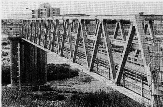
▲ 日名水源取水塔で確保された水は六供浄水場へ送水
