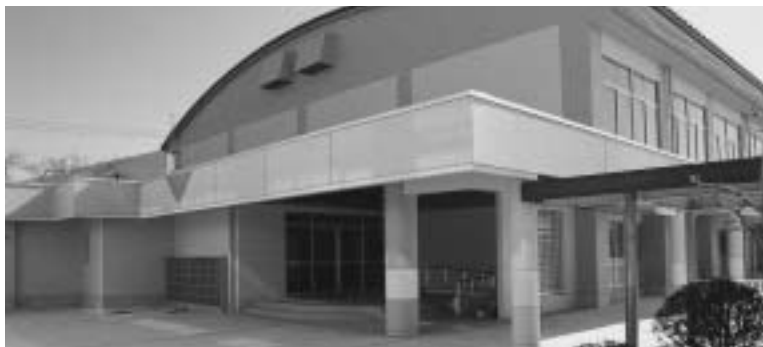
▲屋内運動場増改築 平成14年度完成（六名小学校）
