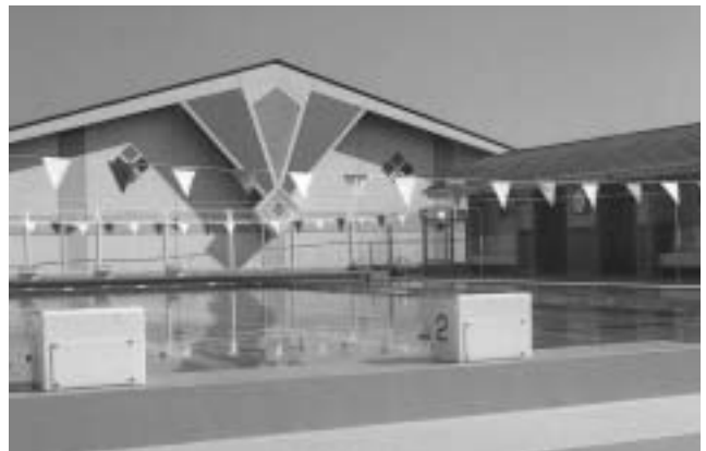
▲プール建設 平成14年度完成 (愛宕小学校)
