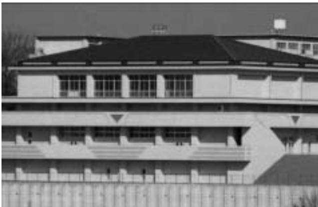
▲屋内運動場増改築 平成14年度完成 (竜海中学校)
