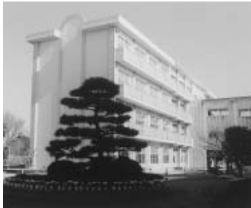
▲校舎増改築 平成13年度完了 (城南小学校)
