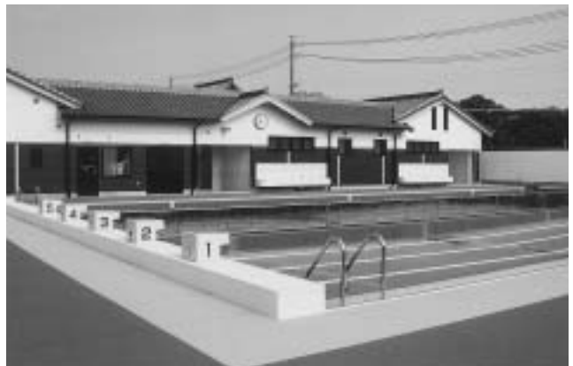
▲プール建設 平成13年度完成 (大樹寺小学校)
