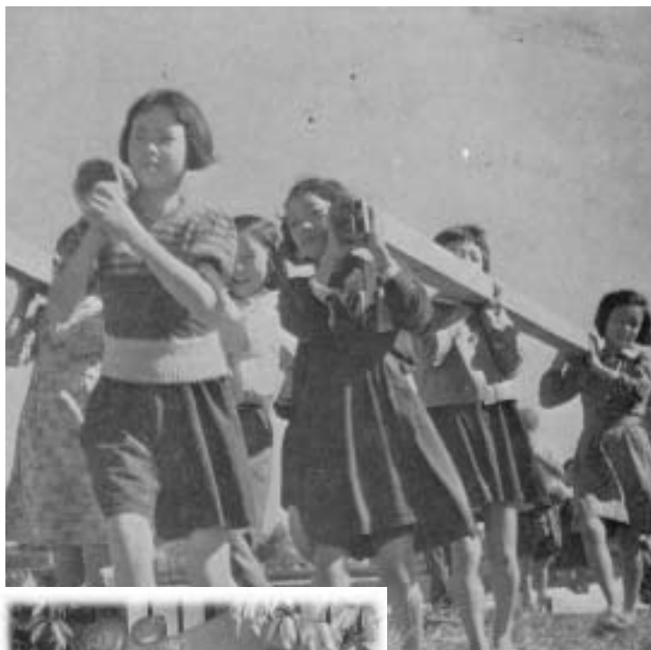
▲学校の復興作業 (連尺小・昭和22年)
