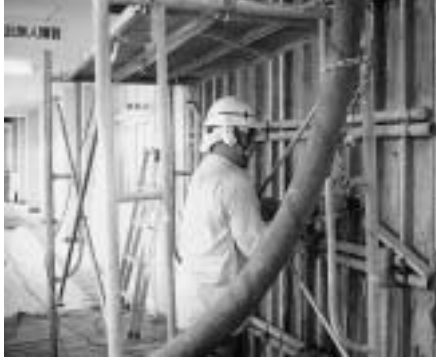
▶各校で進む耐震工事(城北中学校)
