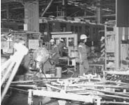
▲取りはずされたパンタグラフ
