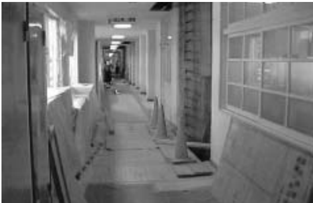
▲校舎耐震補強 (城北中学校)
