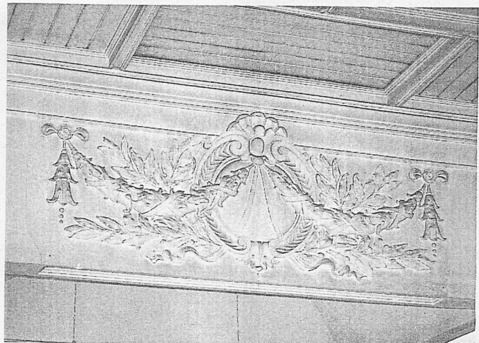
▲ 壁面上部を飾る漆喰の浮き彫り
