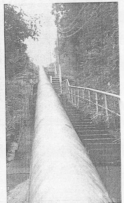
▲有効落差約54メートル 95メートルの送水パイプ
