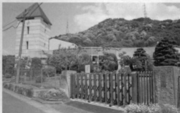
▲ 夏山小門扉整備
