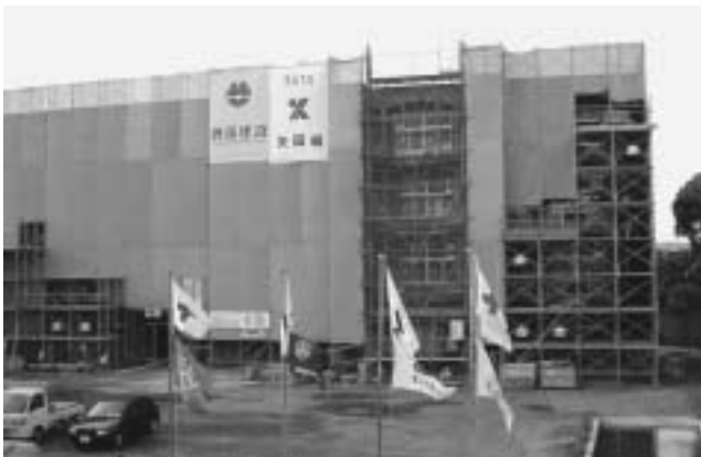
▲校舎改築事業 平成16年度完成 (梅園小学校)
