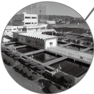
▲半世紀にわたり浄水を供給した男川浄水場
