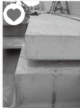
▲沈殿池の底に設置した排泥用のプレート
