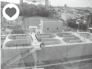
▲水中の不純物を吸着する活性炭に約20分間接触させる粉末活性炭接触池 (旧施設の約4倍)
