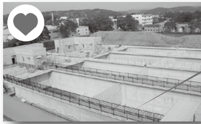
▲底にたまる泥を効率的に排除する凝集沈殿池
