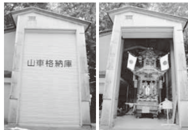
▲ 高さ7mの山車を保管する格納庫
