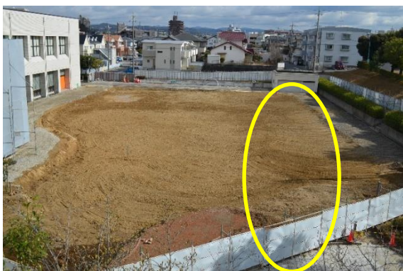
建物がなくなり更地に (令和2年2月18日撮影)
