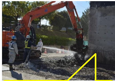
解体用車両進入口を作るため、リハーサル室は解体済み
