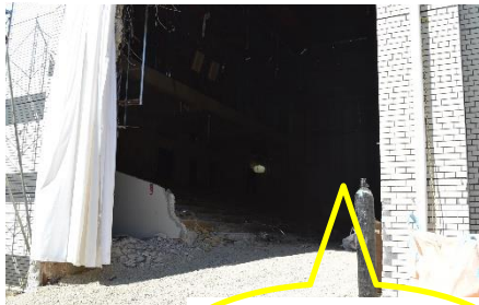
解体用車両が入るために開けた外壁
