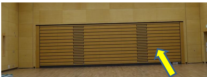
③ ホール後方 壁面にあるこれは何でしょう？ ※階段状になって椅子が出てきます。
