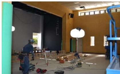
④ 多目的ホールの内部
