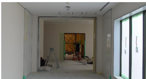
③ 正面入り口から多目的ホールへの通路
