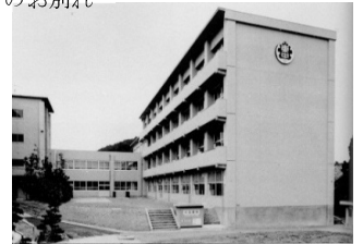
昭和58年 北校舎完工
