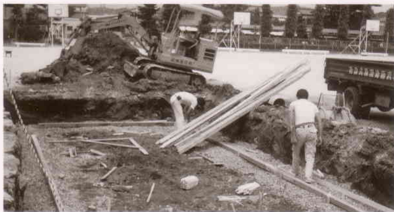
砂場新築工事
