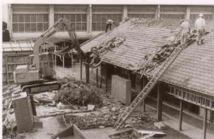
旧校舎取り壊し
