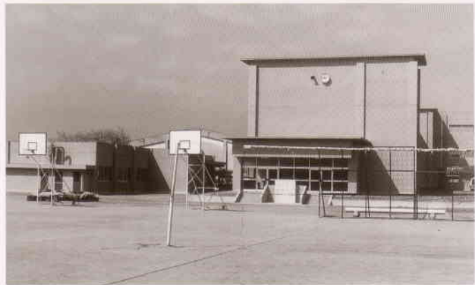
南舎・技術棟完工
