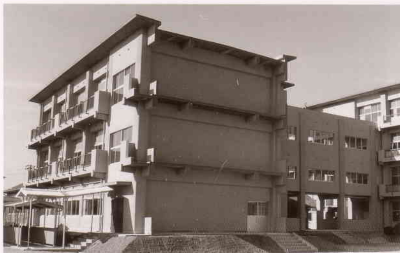
南舎・渡り廊下完工
