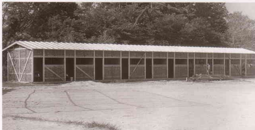
建設中のクラブハウス
