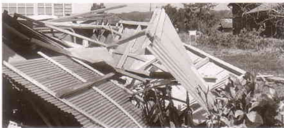
台風18号による車庫倒壊
