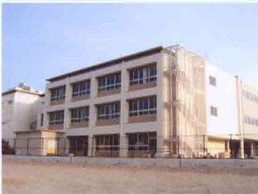
みあい養護学校 校舎の外観
