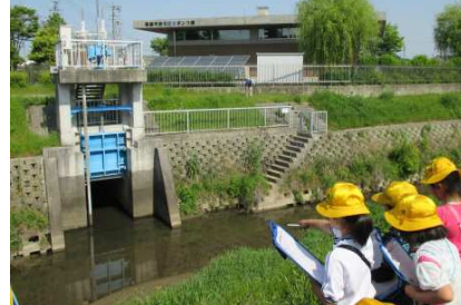
雨水ポンプ場の排水口見学
