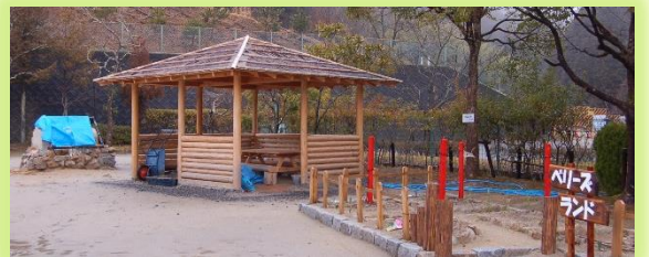
石窯・東屋・ベリーズランド完成(H20)
