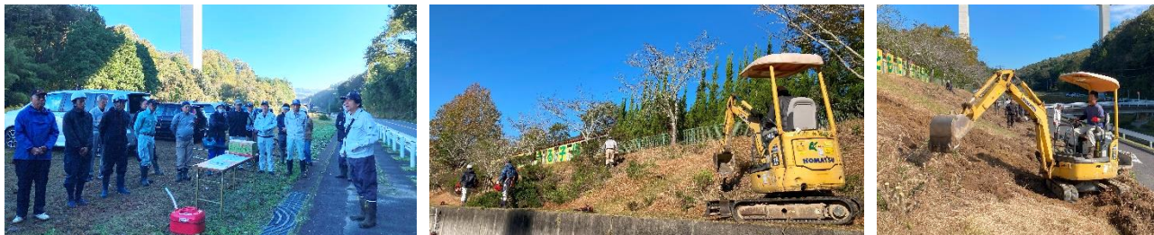
11/12 土入れ・地盤固め
