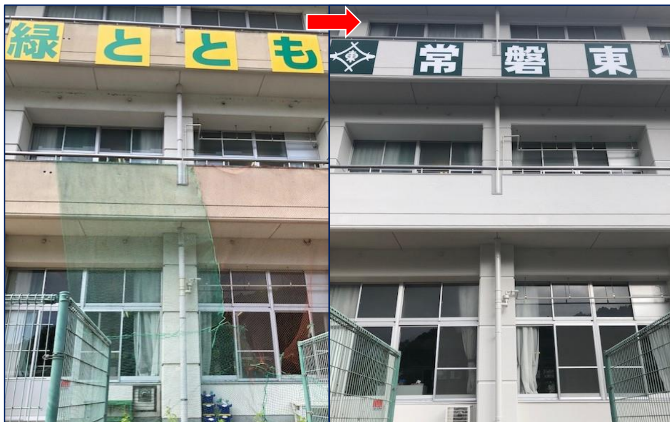
★教室棟壁面 石油ストーブ排気口を囲むカバーまで再塗装の徹底ぶり
