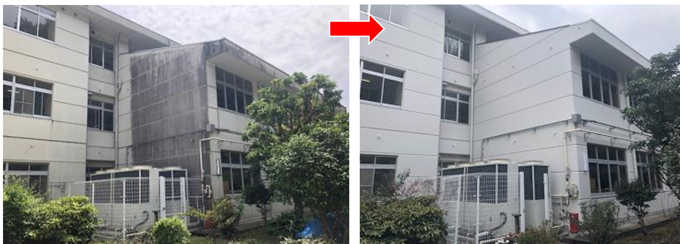
★教室棟北側・オープンスペース側面 激変その2。
