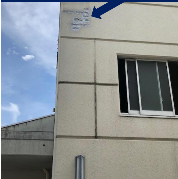
各所のクラック(裂け目・割れ目)補修
