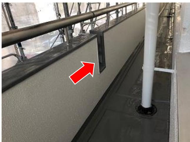
有難いのは、<sup>てすり</sup>手摺が設置されている「ベランダ壁面上部」や、赤➡で示した「風抜け穴」の表面にも、床面と同様のコーティングが施されている点だ。
