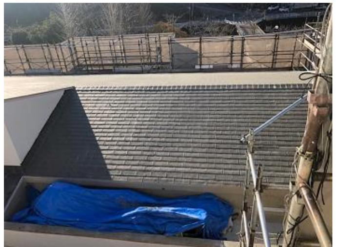
コケだらけだった管理棟(職員室のある棟)の屋根もご覧のとおり。痕跡<sup>むね</sup>すらない。<sup>こんせき</sup>防水コーティングが施された状態。屋根の状態は、ちょうどベランダ床と同じ状態で防水コーティングが施された状態。このあとにチョコレート色に塗装し、屋根は完成となる。
