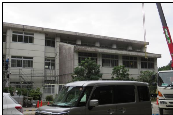
校舎北にはクレーンも入っています
