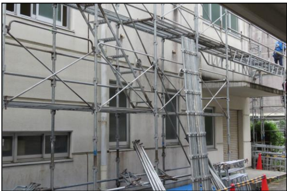
校舎周りに足場が組まれています
