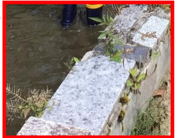
石の街「常磐」らしく、ギョギョランド池の縁(へり)は、大きめの石をモザイクにして貼り付けて彩られ、施工当時のお洒落な工夫の跡がうかがえる。けれども、年月の積み重ねによる風化と、多少の土があれば自生する植物のたくましさに押し切られ、石板が浮いたご覧のような有様である。場所によってはモザイク片の欠落さえ確認できる。
