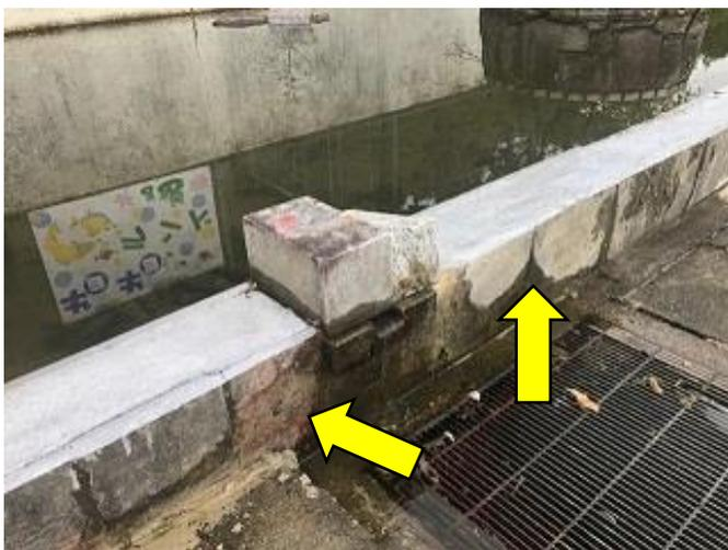
上部のモザイク片を全て<sup>はっ</sup>り、土を取り除いた後にモルタルで処理してある。さらにモルタルの仕上げは、表年が乾く前に刷毛で長手方向になぞる。敢えて表層に「ざらつき」を作る。【滑り止め】である。作業が丁寧である。
