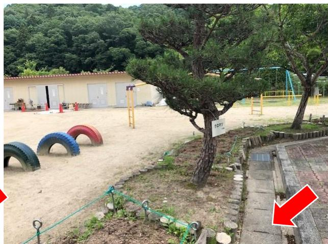
〔左〕 クロマツの記念植樹に土を盛る当時の中根市長。幹の太さと風合いが年月の経過を物語る。当時の側溝蓋（赤➡）はグレーチング。現在は「詰まり」を起こす引き金となっているコンクリート製。変更の理由は不明である。
