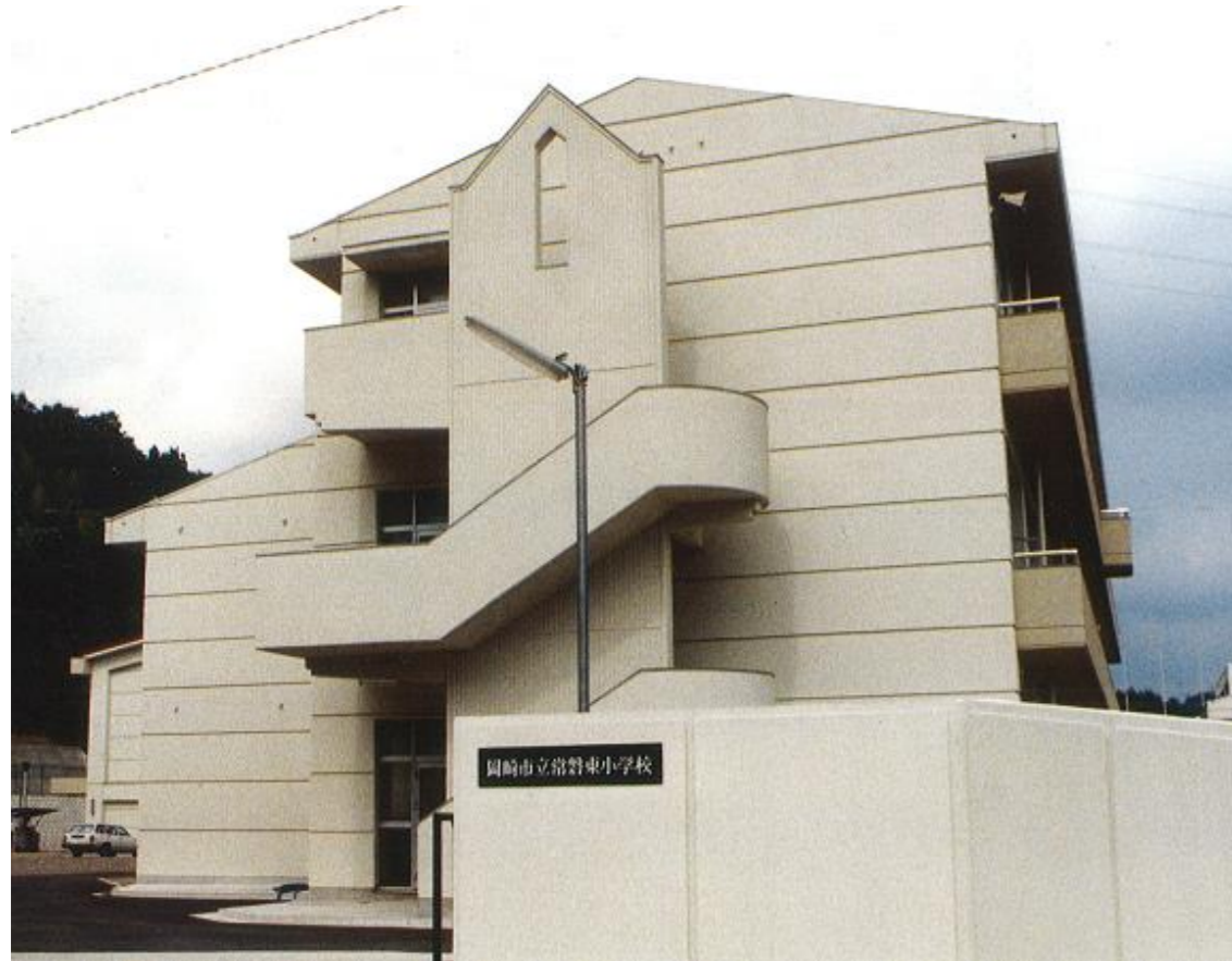
★西門から見た校舎(昭和62年と令和2年)
