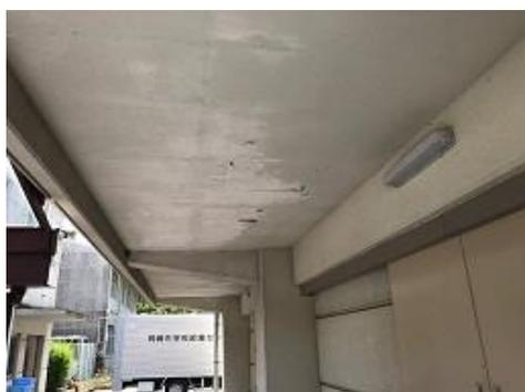
☞左は体育館の軒天井、☞右は非常階段の下部。いずれも塗装劣化による剥がれだが、風雨が当たらない部分に損傷が見られる。
