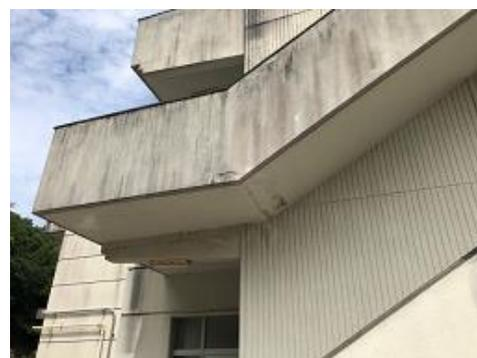
外装の中でも風雨が当たらない部分なので、もともと塗装が薄いのだろう。弱い部分から傷むのだ。
