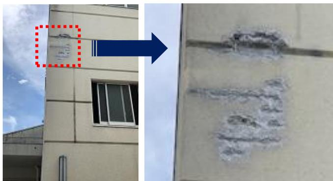
☞左は北校舎の体育館に面した外壁。昨年、岡崎市の現業事務所作業班の方に、応急措置を施してもらった。処置前は壁面にひびが生じ、崩落手前であった。こうした現象を「爆裂」と呼ぶらしい。
