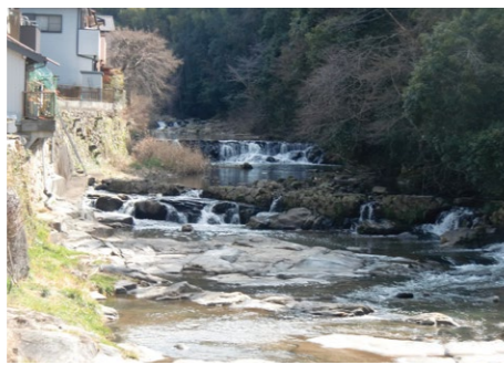
E 青木川の堰堤 かつてはここでガラ紡績の水車が回っていた。堰堤には当時の水車の跡が今も残されている
