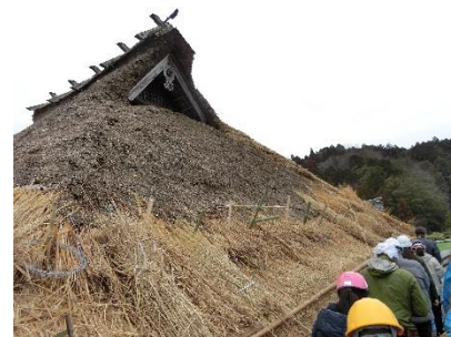
屋根の工事の様子
