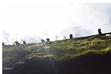
工事前の屋根の様子
