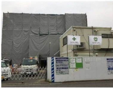
▲復原工事中の旧本宿村役場 (2021年8月撮影)
