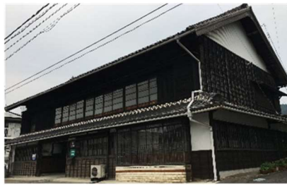
▲建築的特徴 …木造2階切妻造、棧瓦葺、平入り 外壁は簾子押縁下見板張り
