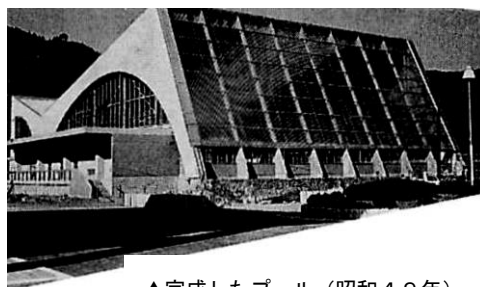
▲完成したプール（昭和49年）
