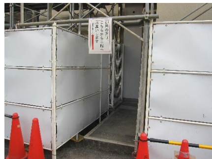
【職員室への非常階段入口】
