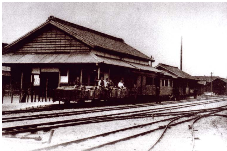
初代の西尾駅。現在の西尾駅より400m西側にあった。曲線が多く電化しにくかったため、1928(昭和3)年に現在の場所に移転した。天王門駅はこの時、廃駅になった。 早川氏提供
