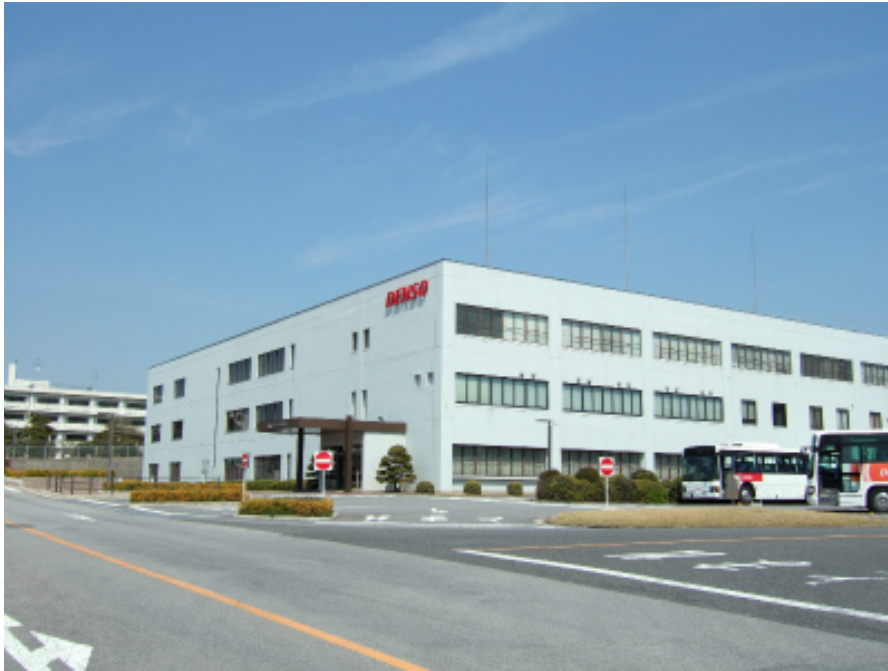
デンソー西尾製作所 事務棟
