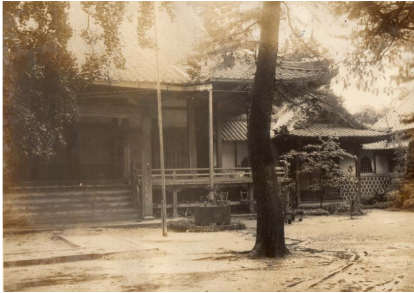
浄光寺本堂 1939(昭和14)年 浄光寺提供
